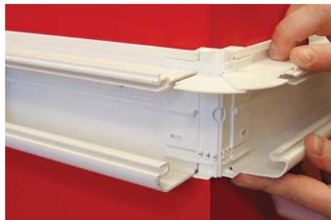
Вставьте в базу угла вторую часть короба. Закрепите короб на стене
